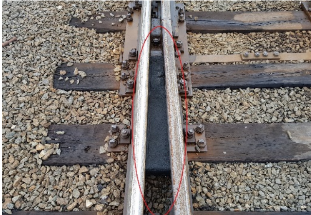
Bild 2 Exempel på monterad skyddsklots - OK
