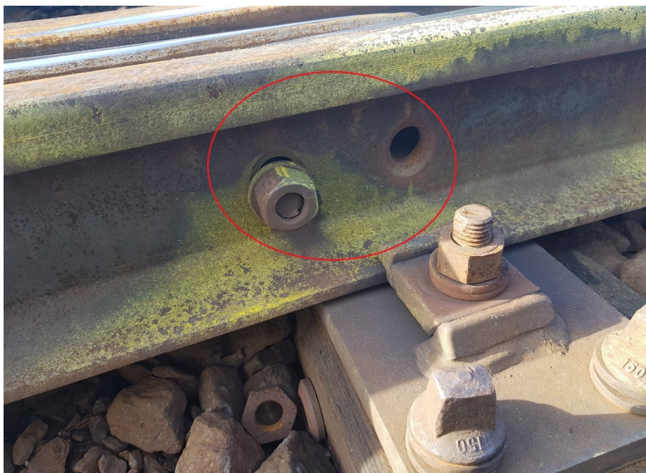
Bild 3 Exempel: Två eller fler skruvar / muttrar saknas eller sitter löst - Akut
