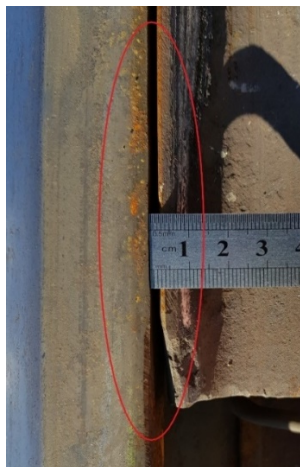
Bild 1 Visar glapp > 2 mm mellan tungspets och stödräl - Akut
