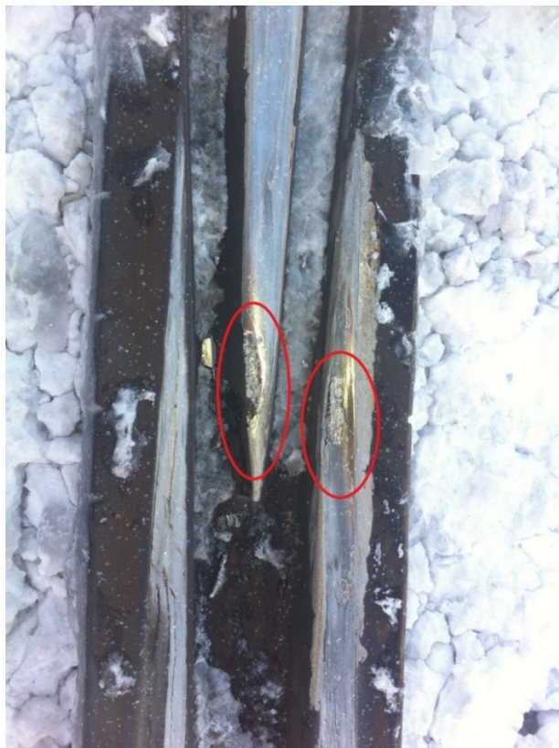
Bild 5 Exempel: Skador på spets och vingräl - Akut
