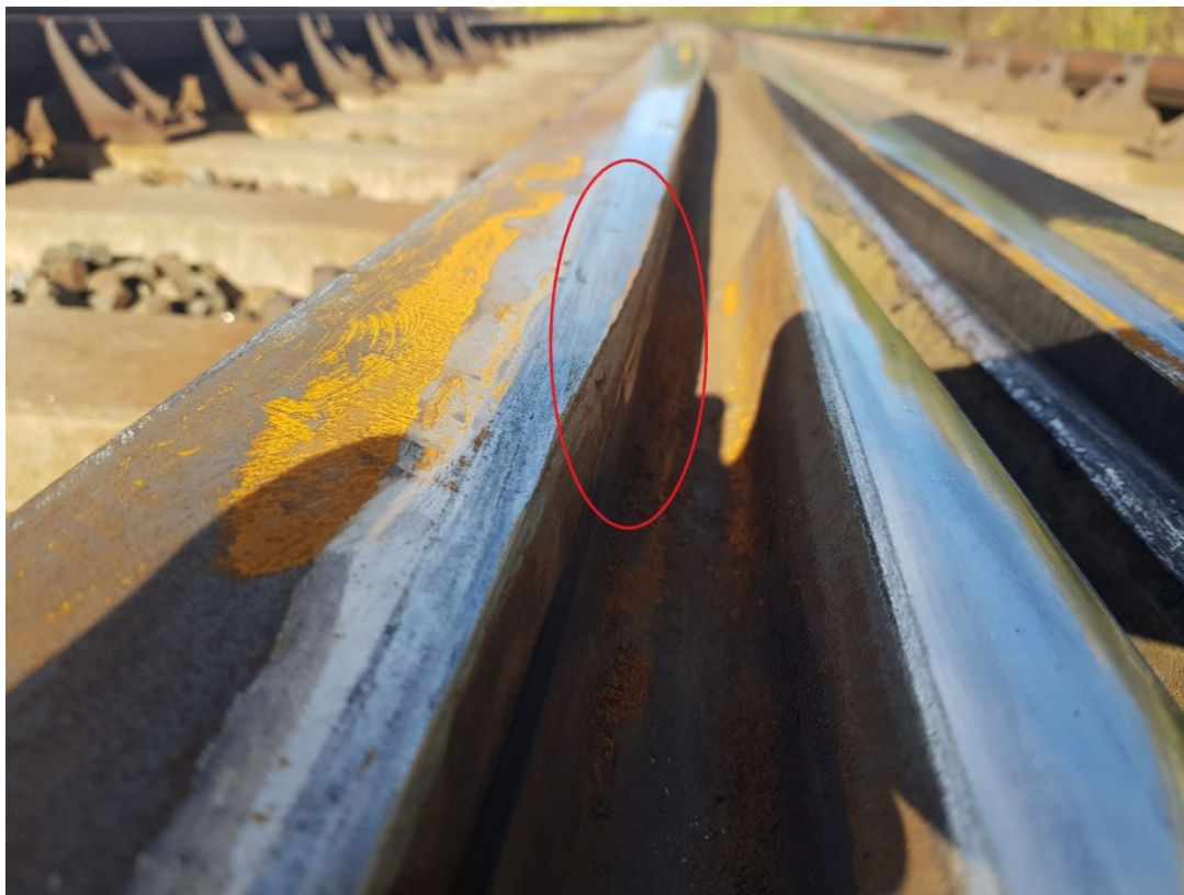
Bild 10 Exempel: Övervalsning med skarp kant på vingräil. - V
