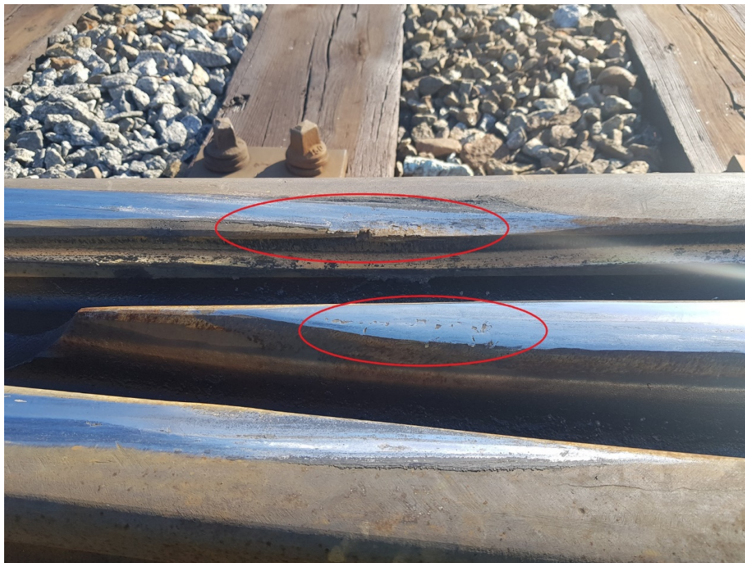
Bild 12 Exempel: Ytdefekter spets och övervalsning vingräl. - V
